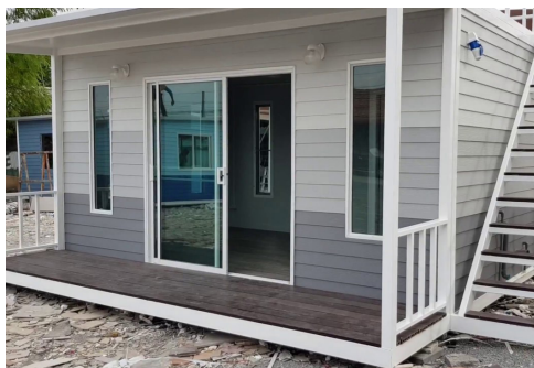
บ้านประกอบเสร็จ
